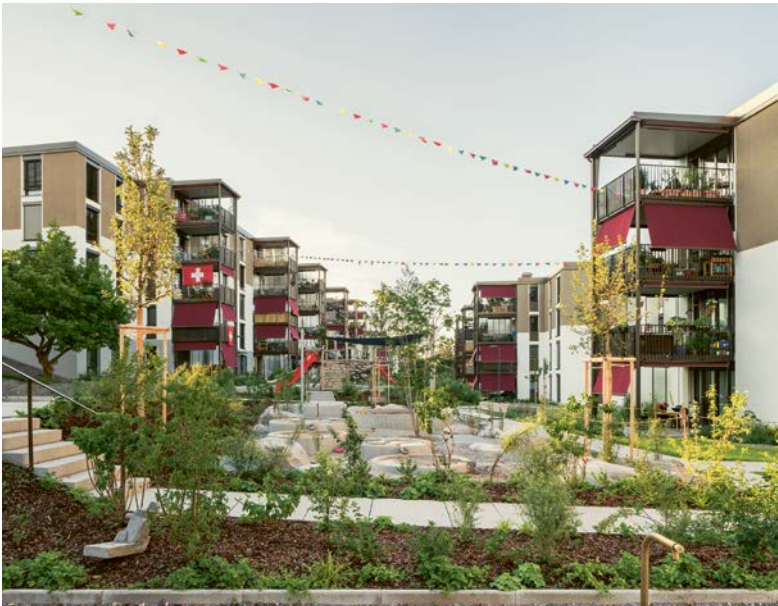
7.8 Shared central courtyard of the Ersatzneubau , Entlisberg, 2018
