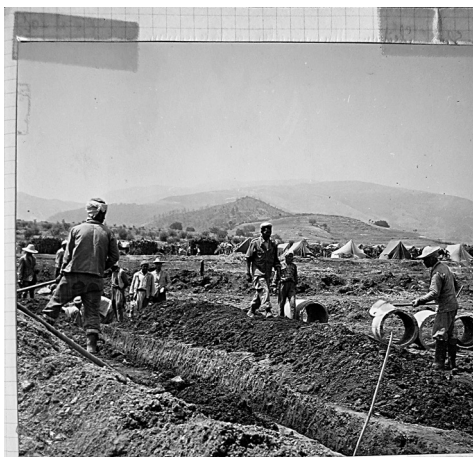
Debut des Travaux de construction du Village de Regroupement CHEQA : II - (16.01.59-
