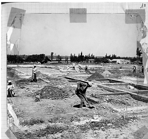
Debut des Travaux de la Cité Revale a AMROUSSA -
