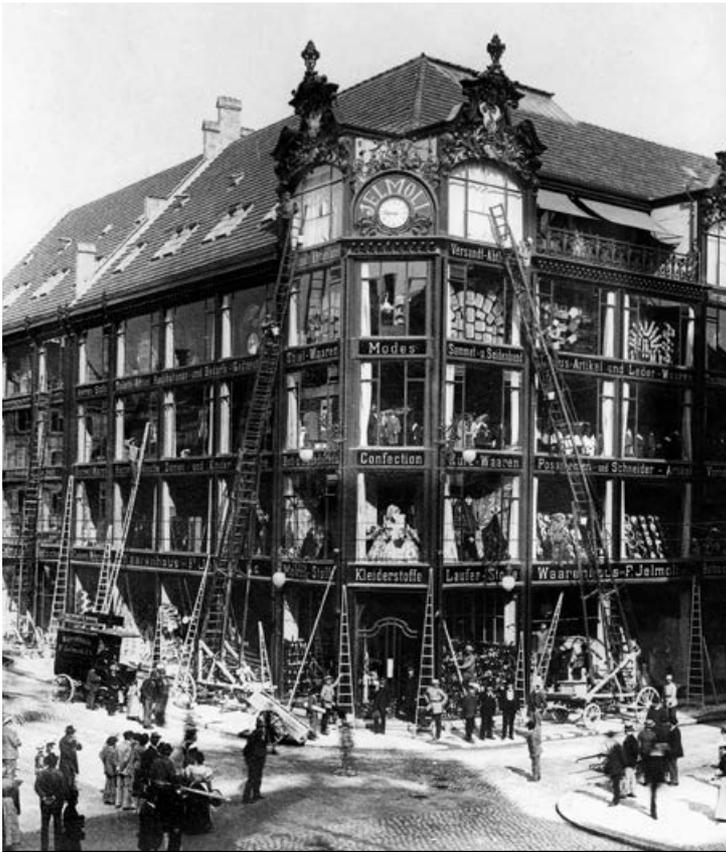
Flächige, vorgehängte Fassade aus Glas und Eisen, aufgesetzte Dekoration. Das 1898 bis 1899 an der Seidengasse von Stadler & Usteri errichtete Warenhaus Jelmolli. (BAZ)
