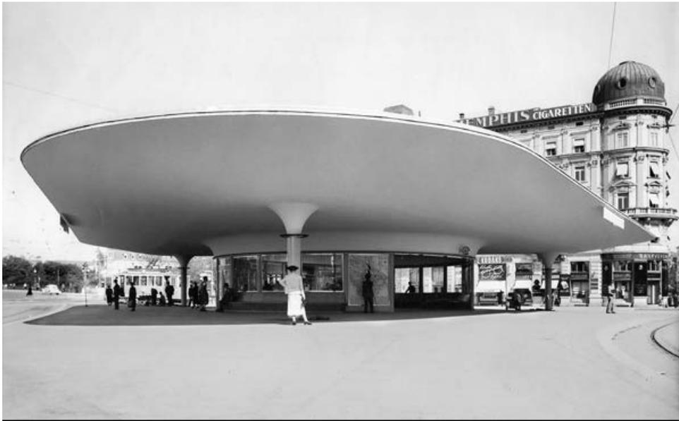
Die Tramwarte Halle am Bellevue wurde von Hermann Herter 1939 als ästhetische Verkörperung der fließenden Formen des Verkehrs gestaltet. Eine Stahlkonstruktion erlaubte das weite Auskragen der Vordächer. (BAZ; Foto Michael Wolgensinger 1939)
