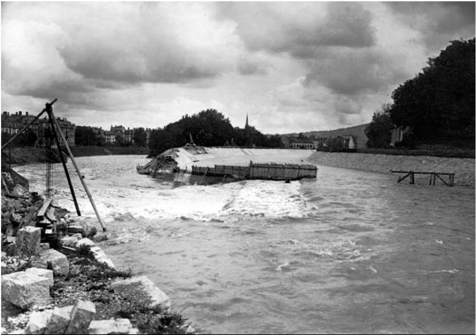
Die Tieflegung der linksufrigen Zürichseelinie erforderte die Verlegung der Sihl beim Sihlhölzli. Links das alte, rechts das neue Flussbett um 1920. (BAZ)
