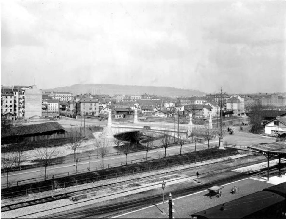
Die 1899 von Robert Maillart und Gustav Gull als Betonbogen erbaute Stauffacherbrücke verbindet Aussersihl mit der City. Am linken Sihlufer weisen Brandmauern auf intensive Bautätigkeit hin: Dort liessen sich typisch städtische Branchen wie Zeitungsverlage, Druckereien und Textilkonfektionsbetriebe nieder. (BAZ)
